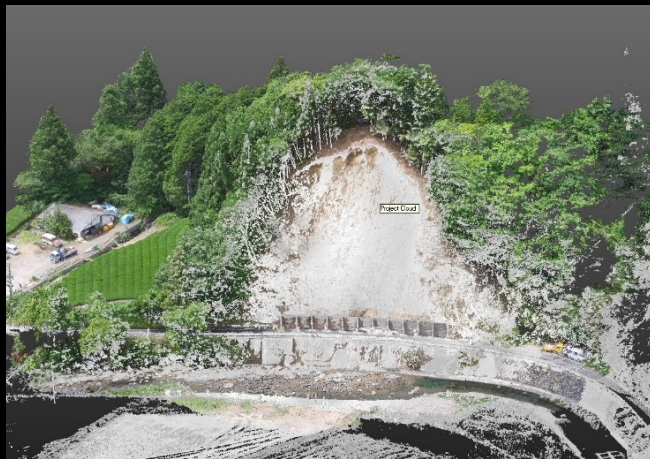
被災後の3次元点群データ
