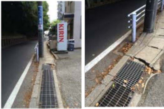
①歩道の段差 解決前
