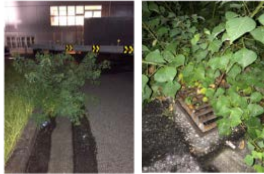
②集水桝の詰まり 解決前
