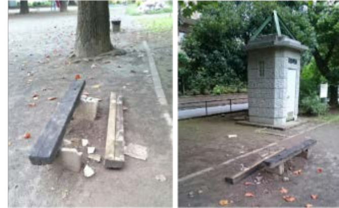
③公園のベンチ破損 解決前
