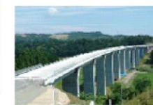
橋梁の維持管理
